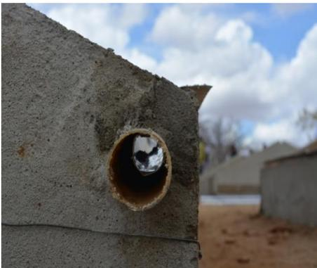
**12º Passo:** Preparação do pré-moldado frontal para colocação do tubo de alumínio
