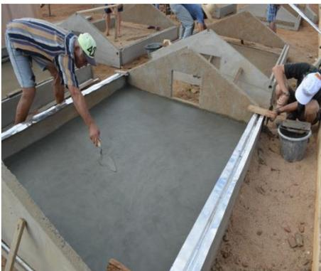
**16º Passo:** Colocação do tanque para armazenamento de águas salinas
