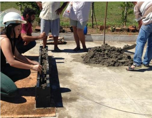
**12º Passo:** Fechamento da parte superior da forma lateral após aplicação de argamassa
