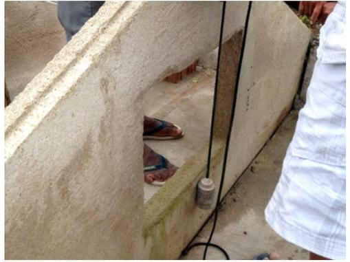
**11º Passo:** Abertura do orifício para colocação das calhas
